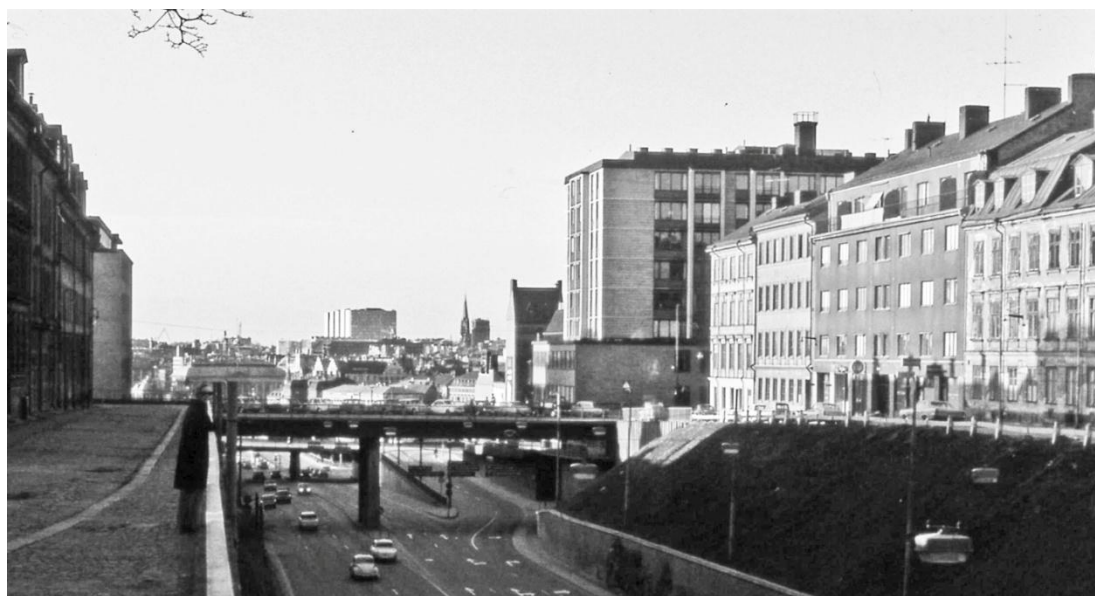
Södergatan norrut 1973 innan den däckades över och byggdes om till Söderleden. (Foto: Pär-Erik Nordin)
